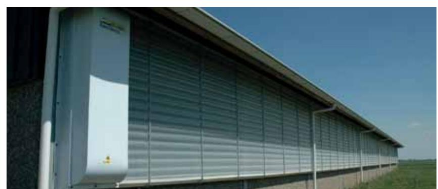
Lumitherm представляет собой надуваемую систему вентиляции для комбинированного обеспечения светом, воздухом и вентиляцией. Благодаря своей конструкции из соединенных между собой рукавов образуется закрытая стена из светопроницаемого пластика.
